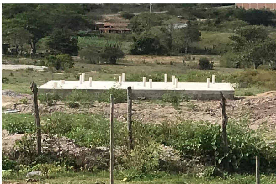
Figura 4.5 - Fossão recém-construído no Conjunto Joseilton Belarmino
