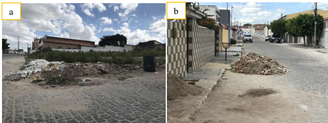
Figura 6.18 - a) e b) Disposição de RCC em frente as obras no município de Esperança/PB
