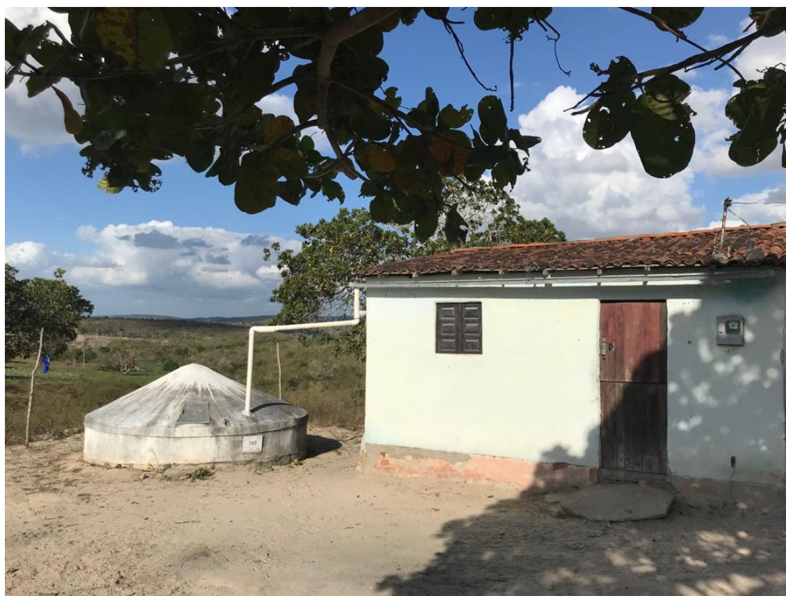
Figura 3.27 - Captação de água de chuva com armazenamento em cisterna no povoado de Pintado
