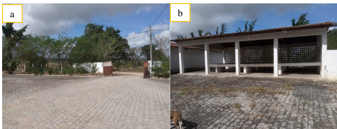
Figura 6.28 - Lixão municipal no município de Esperança/PB: a) presença de cercamento, portão e cinturão verde; b) pátio de separação dos recicláveis
