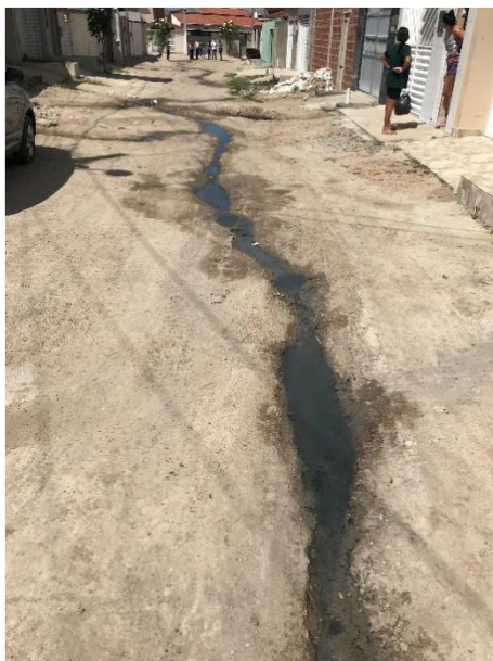
Figura 4.16 - Esgoto a céu aberto na rua João Nascimento
