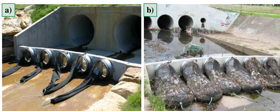
Figura 4.3.7 – Rede para contenção de resíduos sólidos em saída de tubulação de drenagem na Austrália, sem recolhimento de resíduos (a) e com resíduos (b)
