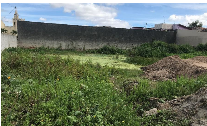
Figura 4.17 - Ponto de acúmulo de água e despejo de esgoto a céu aberto próximo a UBS Mirian de Fátima
