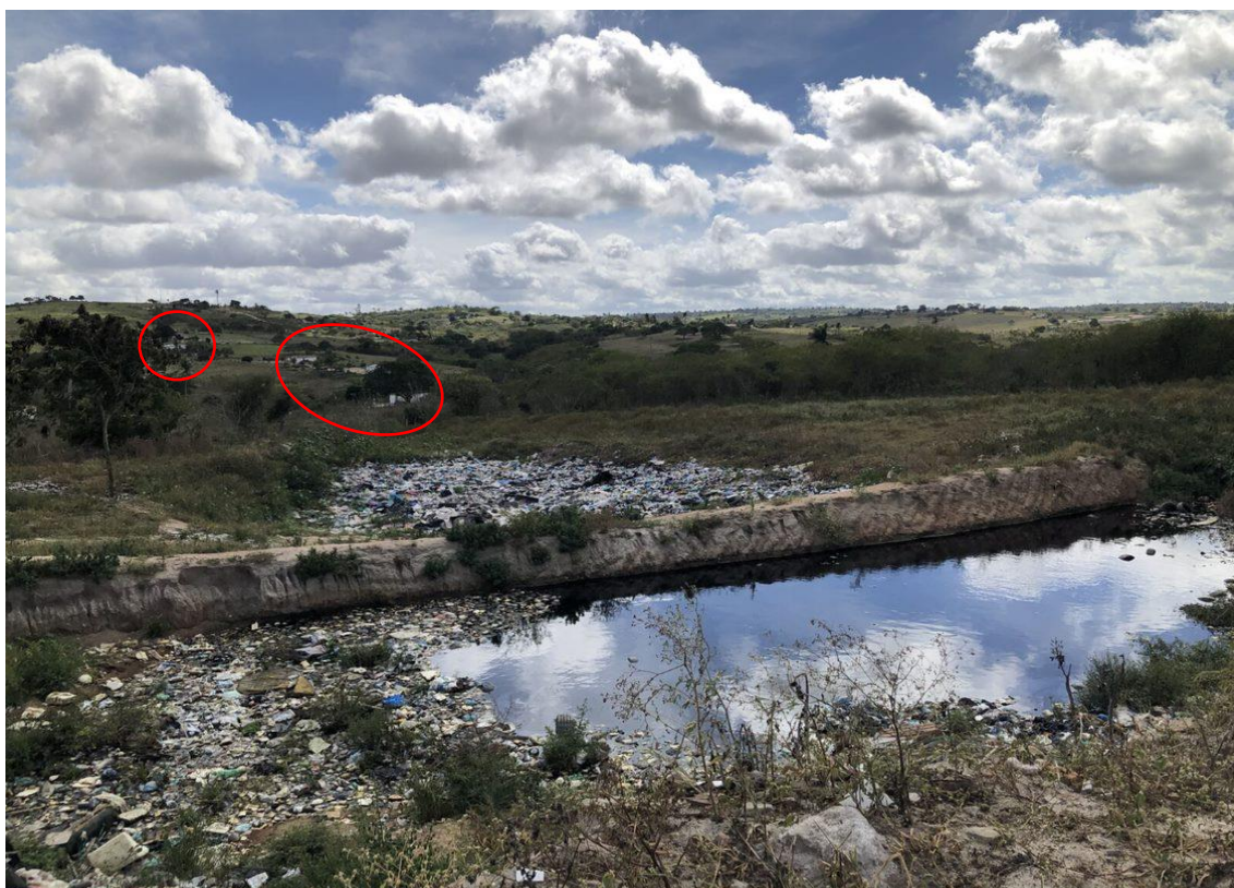
Figura 6.31 - Lagoa de lixiviado no lixão municipal no município de Esperança/PB
