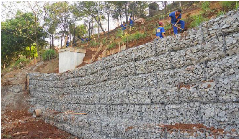
Figura 4.3.24 – Instalação de muro de arrimo para estabilidade de encosta
