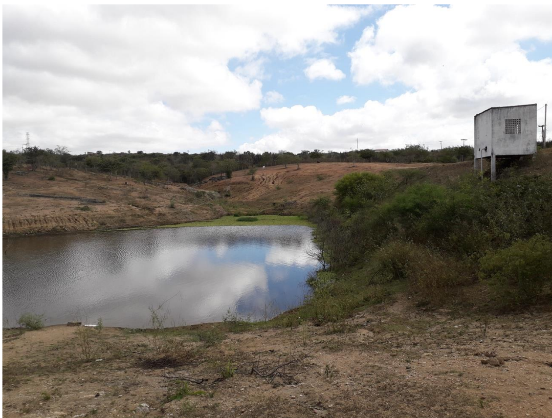
Figura 3.26 – Açude Massabielle utilizado para abastecimento individual
