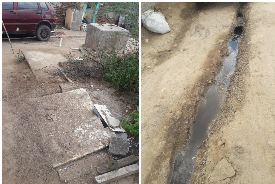
Figura 4.7 – Fossa rudimentar e lançamento de águas cinzas a céu aberto no Povoado Massabielle
