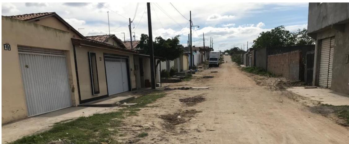
Figura 5.19 – Rua sem pavimentação localizada no Bairro Quarenta
