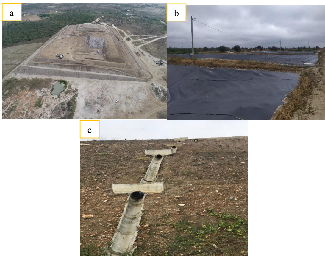
Figura 6.24 - Aterro Sanitário de Campina Grande/PB: (a) foto aérea da macrocélula em operação; (b) lagoa de evapotranspiração de lixiviado; (c) drenagem de águas pluviais
