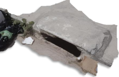
Boca de lobo na Rua Antenor Navarro
